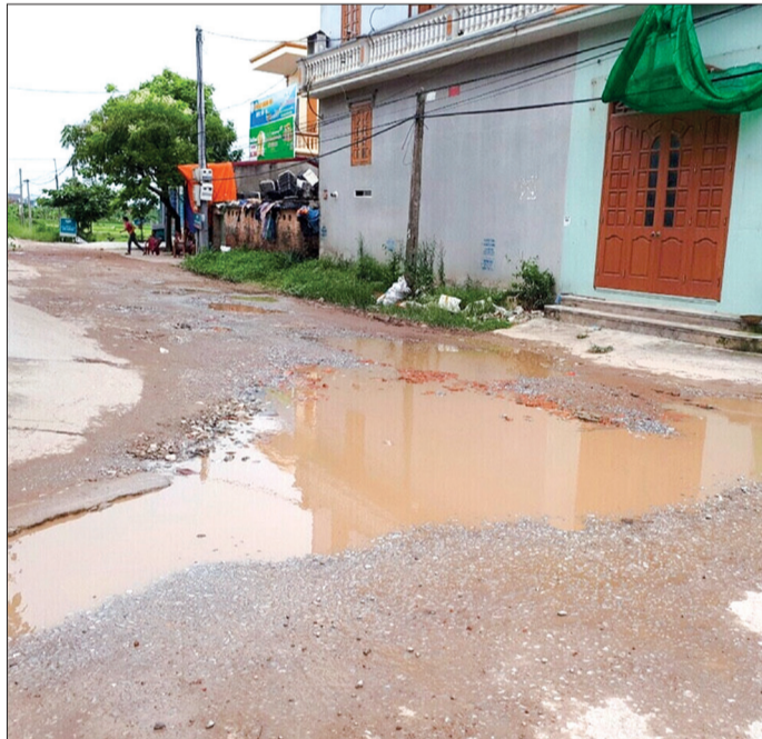
Do xe ô tô chở quá tải trọng né trạm kiểm tra tải trọng xe trên quốc lộ 10 đi theo đường liên xã Đông Giang, Đông Kinh, Đông Vinh (Đông Hưng) làm tuyến đường này bị hư hỏng nặng.
