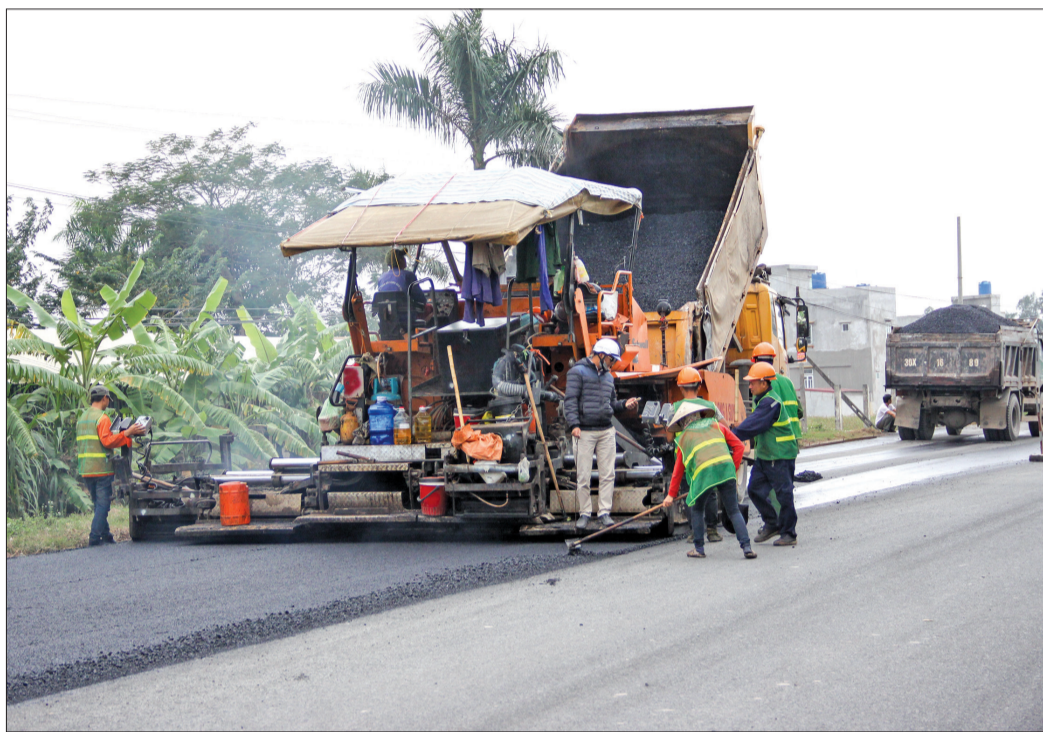
Đơn vị thi công huy động nhân lực, vật tư đẩy nhanh tiến độ thi công quốc lộ 39 đoạn qua địa phận xã Minh Khai (Hưng Hà).
