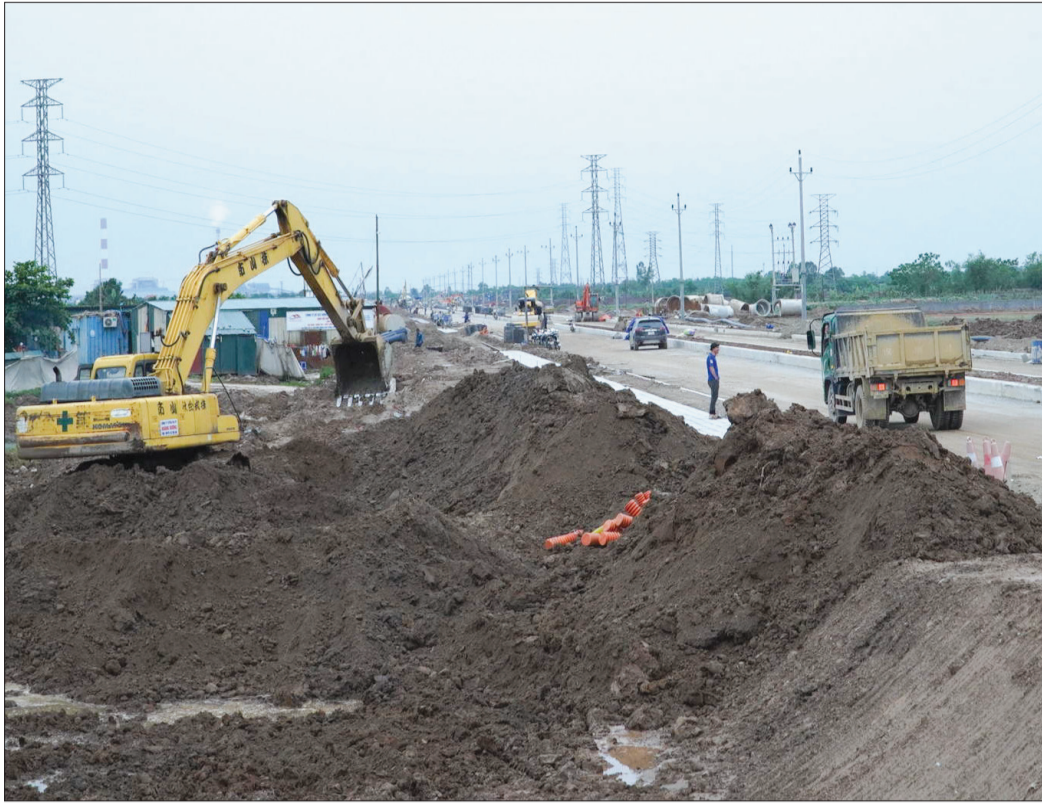
Thi công hạ tầng kỹ thuật khu công nghiệp Liên Hà Thái.
