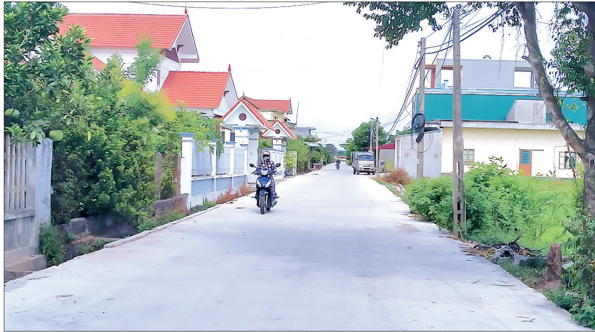
Đường giao thông xã Tân Lập (Vũ Thư) được mở rộng, cứng hóa, giúp người dân đi lại thuận tiện.
