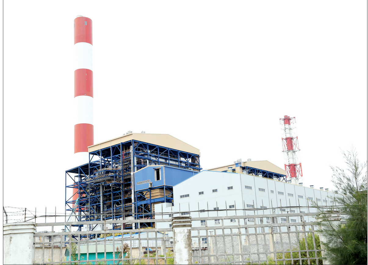
Nhà máy Nhiệt điện Thái Bình 2.
