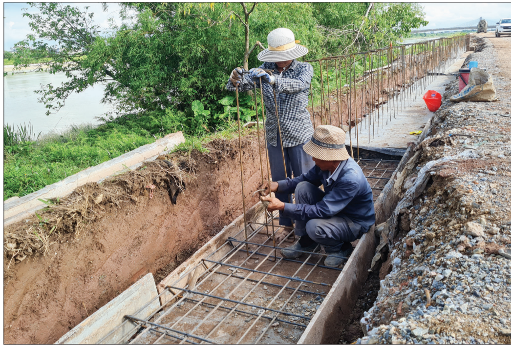
Thi công mặt đê tả sông Trà Lý đoạn qua phường Hoàng Diệu (thành phố Thái Bình).
