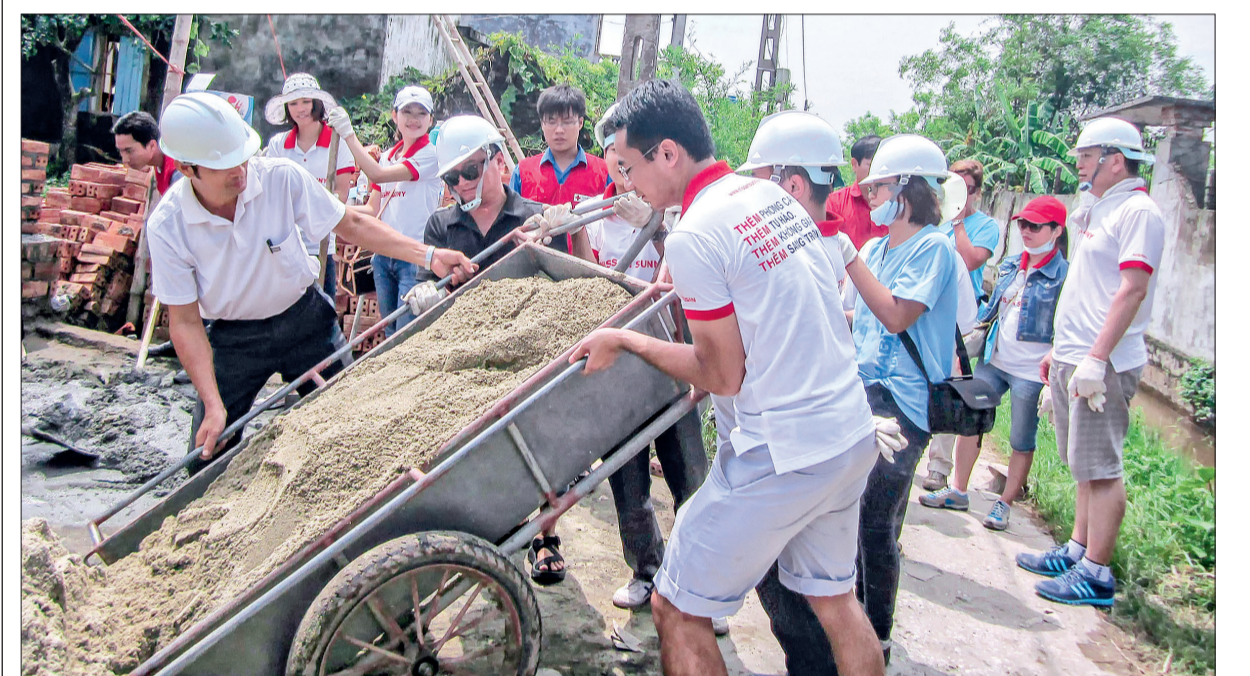
Dự án mái nhà an toàn do tổ chức Habitat for Humanity Việt Nam hỗ trợ xây dựng tại xã Đông Minh (Tiền Hải).
