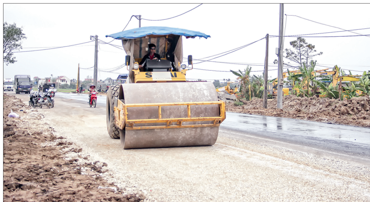
Tuyến tránh thị trấn Đông Hưng dự kiến bàn giao cho chủ đầu tư và đưa vào sử dụng cuối tháng 3/2018.
