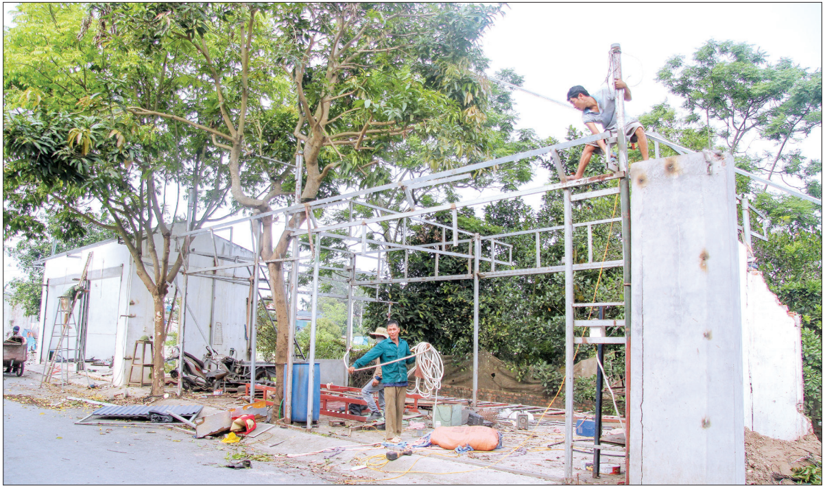
Tháo dỡ công trình xây dựng vi phạm hành lang an toàn giao thông tại thị trấn Hưng Nhân.
