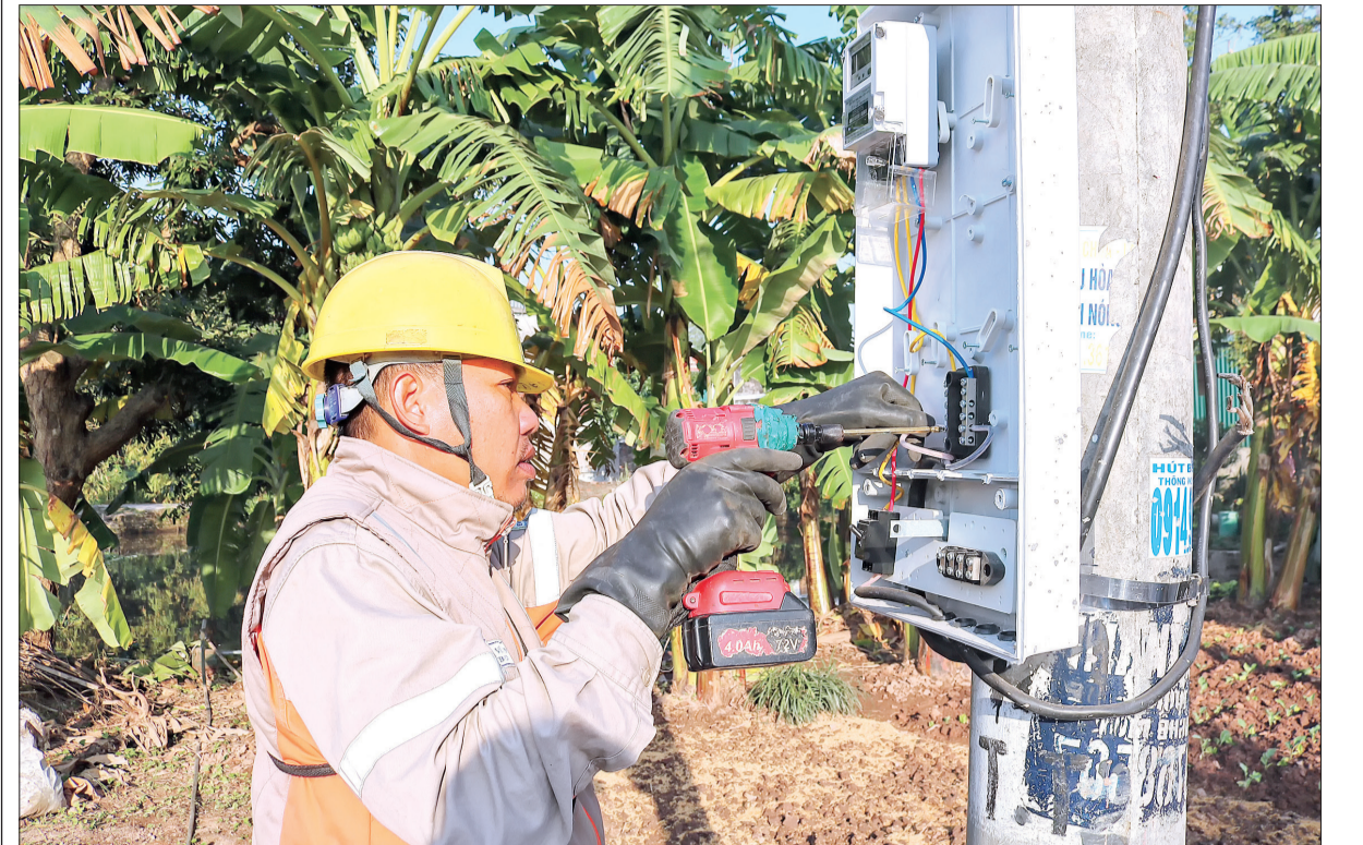
Công nhân Điện lực thành phố Thái Bình lắp đặt công tơ điện tử đo xa tại xã Phúc Thành (Vũ Thư).
