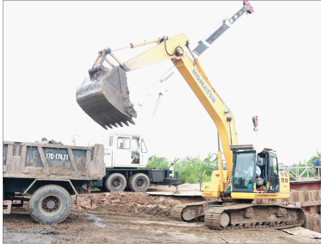
Thi công dự án đường ĐH.95 Thụy Phong - Thụy Ninh.
