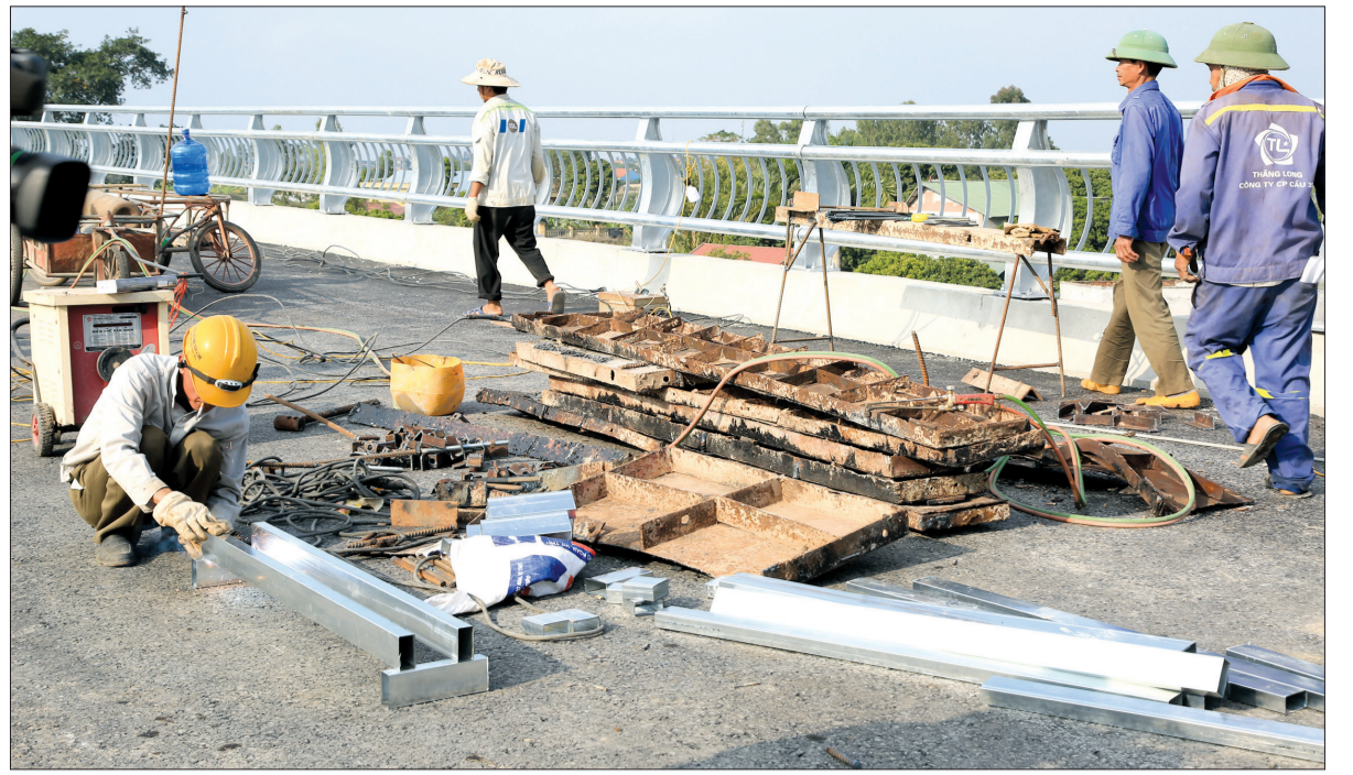
Đơn vị thi công đang tập trung hoàn thiện các hạng mục cầu La Tiến.
