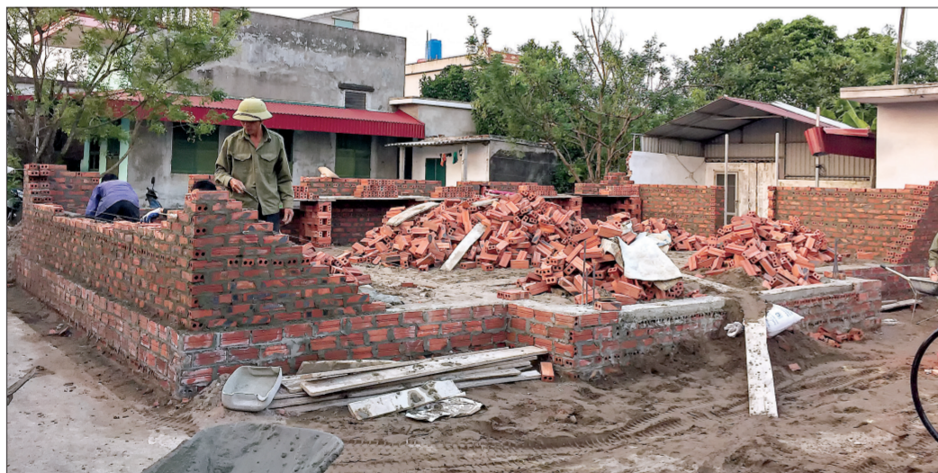
Xây dựng nhà ở cho người có công tại xã Thụy Phúc (Thái Thụy).
