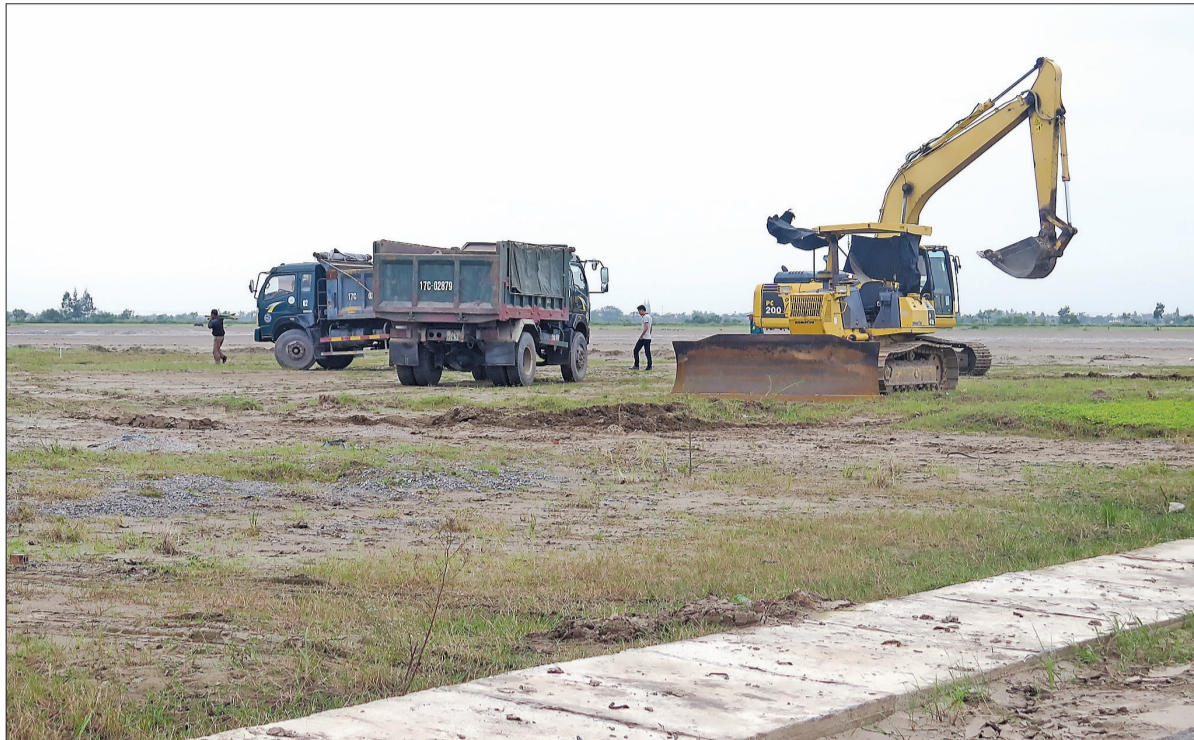
Quỹ đất sạch tại khu công nghiệp Tiên Hải đã sẵn sàng cho nhà đầu tư thứ cấp thuê.
