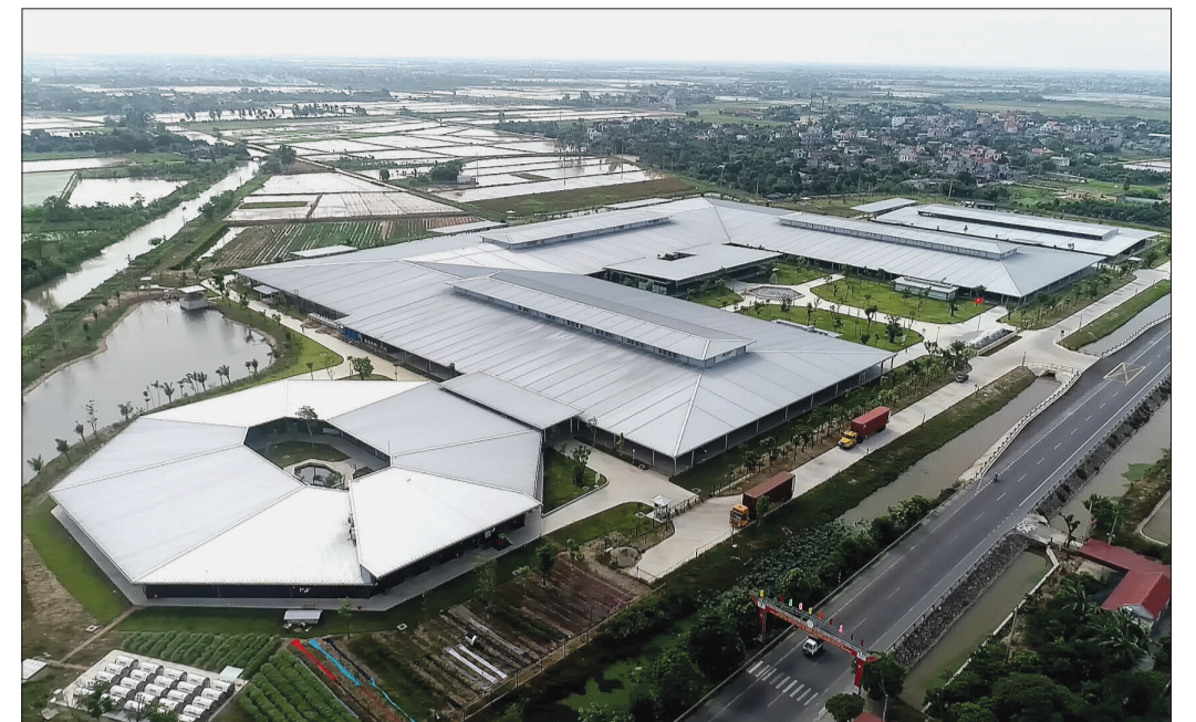
Nhà máy TD10 của Công ty Tân Đệ có tổng mức đầu tư hơn 400 tỷ đồng, được xây dựng theo mô hình nhà máy trong công viên.
