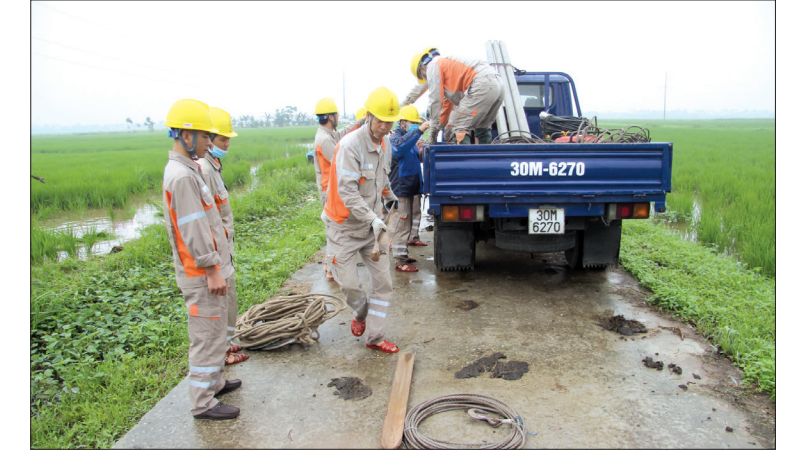
Công nhân Công ty Điện lực Thái Bình triển khai phương tiện, thiết bị xử lý tình huống theo đúng kế hoạch đề ra.
