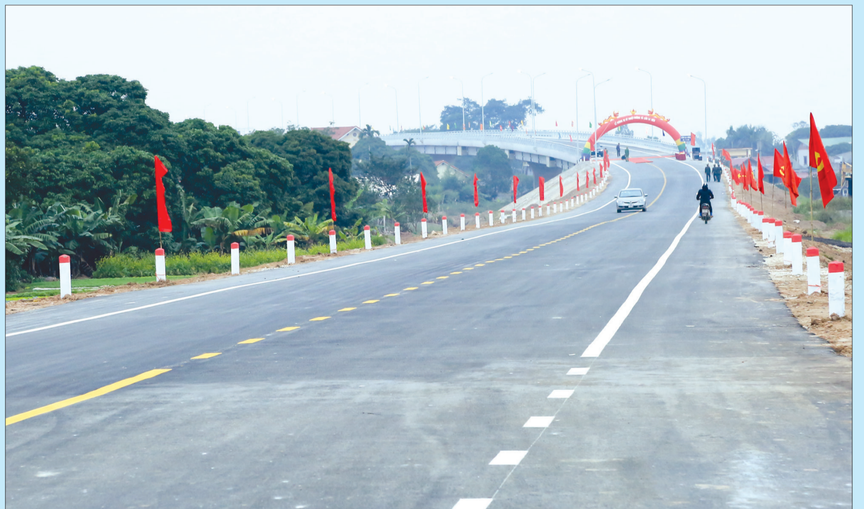
Cầu La Tiến nối hai tỉnh Thái Bình - Hưng Yên.
