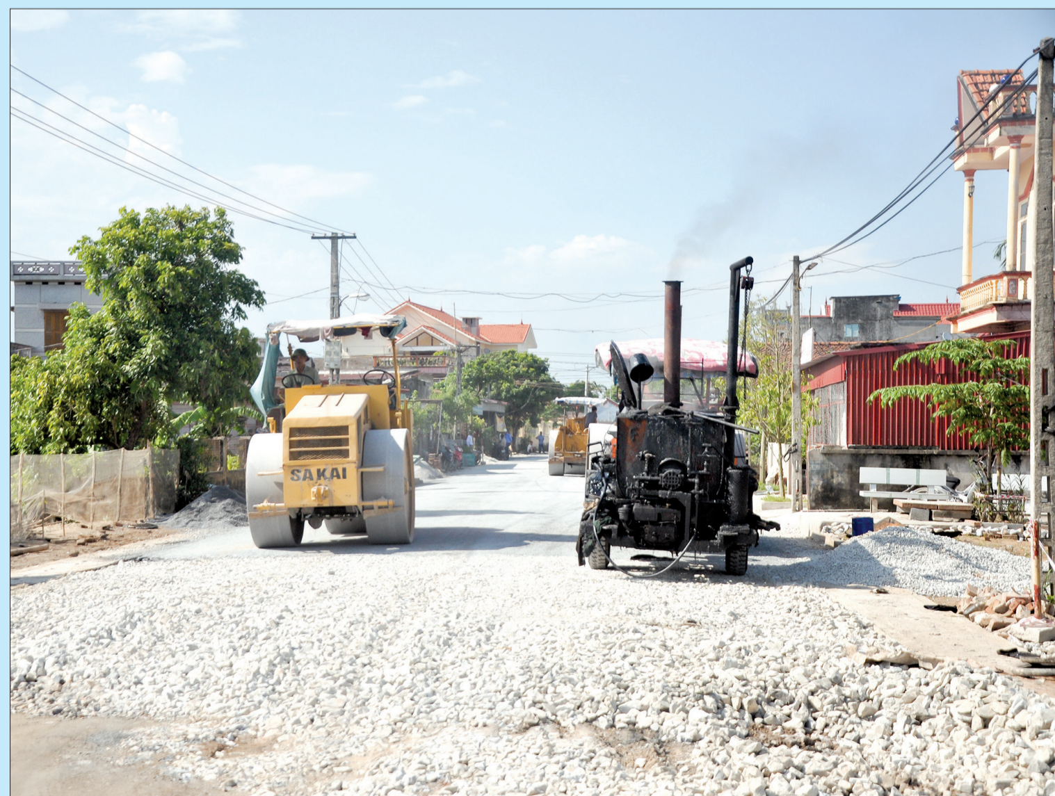
Đẩy nhanh tiến độ thi công đường Thái Thủy - Thái Thịnh.
