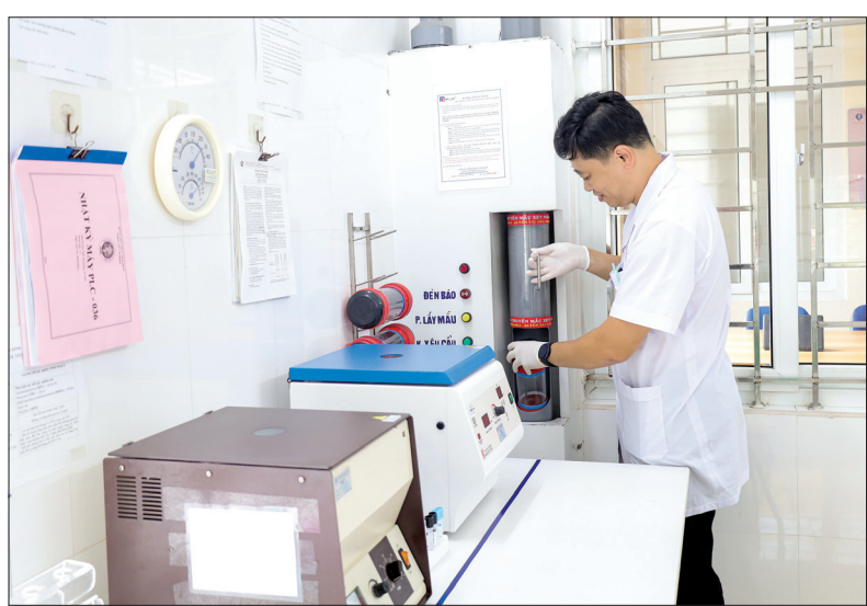
Hệ thống vận chuyển mẫu bằng khí nén tại Bệnh viện Y học cổ truyền Thái Bình có thể vận chuyển được khoảng 1.800 mẫu/giờ.
