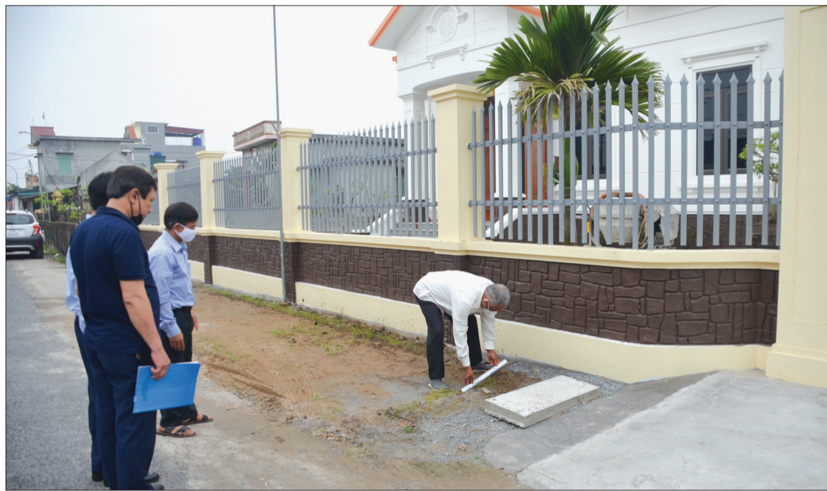
Trước khi xây nhà, gia đình ông Mai Văn Hội, thôn Sài, xã An Quý (Quỳnh Phụ) lùi hơn 2m đất của gia đình để tuyến đường được mở rộng.
