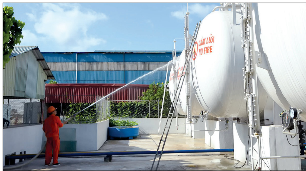
Công nhân Công ty TNHH Việt Xô gas tưới nước làm mát bồn chứa gas.
