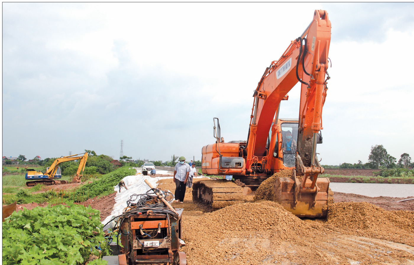
Gia cố để biển số 8, huyện Thái Thụy trước khi bão đổ bộ.
