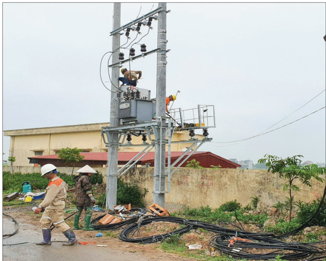
Điện lực Thái Thụy lắp đặt trạm biến áp chống quá tải địa bàn xã Thụy Việt.
