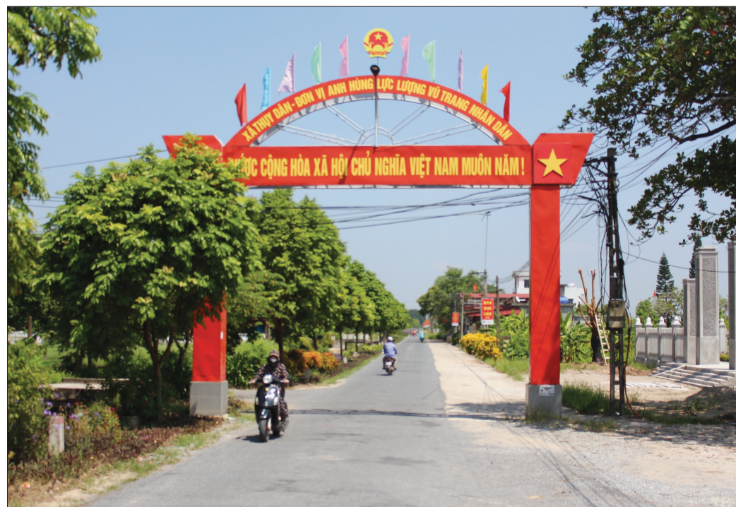
Xây dựng nông thôn mới nâng cao, đường giao thông xã Thụy Dân được nâng cấp, mở rộng.
