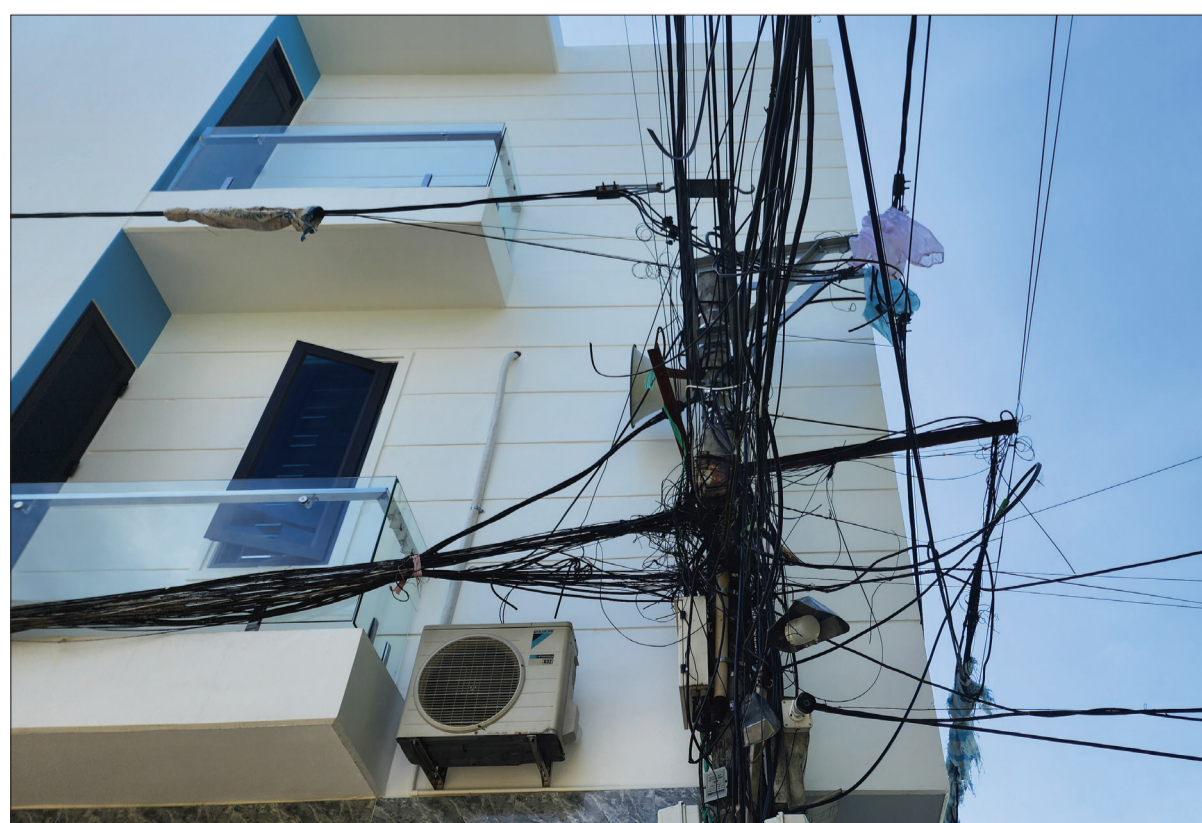
Tuy nhiên, cáp viễn thông khu vực ngõ nhỏ còn chằng chịt.
