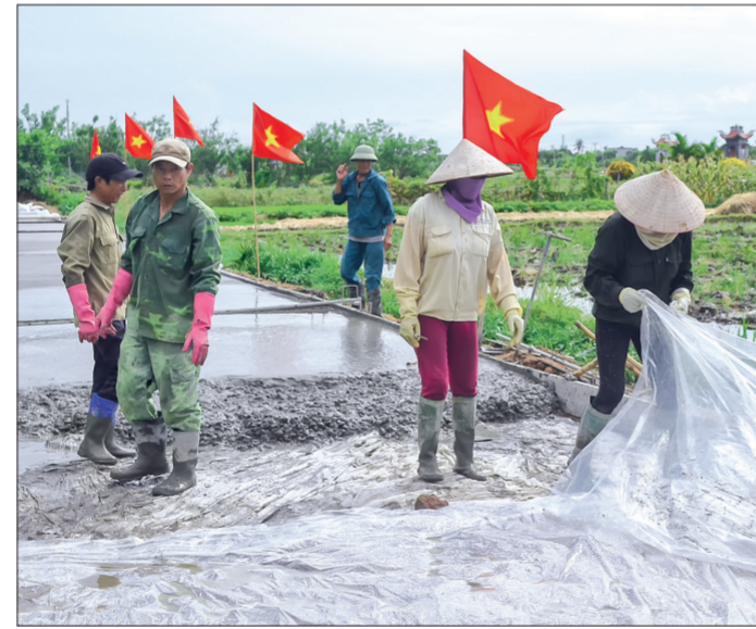
Hội viên phụ nữ xã Thái Dương (Thái Thụy) tham gia xây dựng đường giao thông nông thôn theo tiêu chí nông thôn mới.
