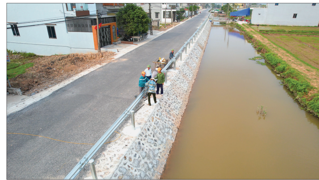
Đơn vị thi công đang hoàn thiện hệ thống bảo đảm an toàn giao thông tuyến đường ĐH.19 từ UBND xã Vũ Bình đến tá Hồng Hà II.
