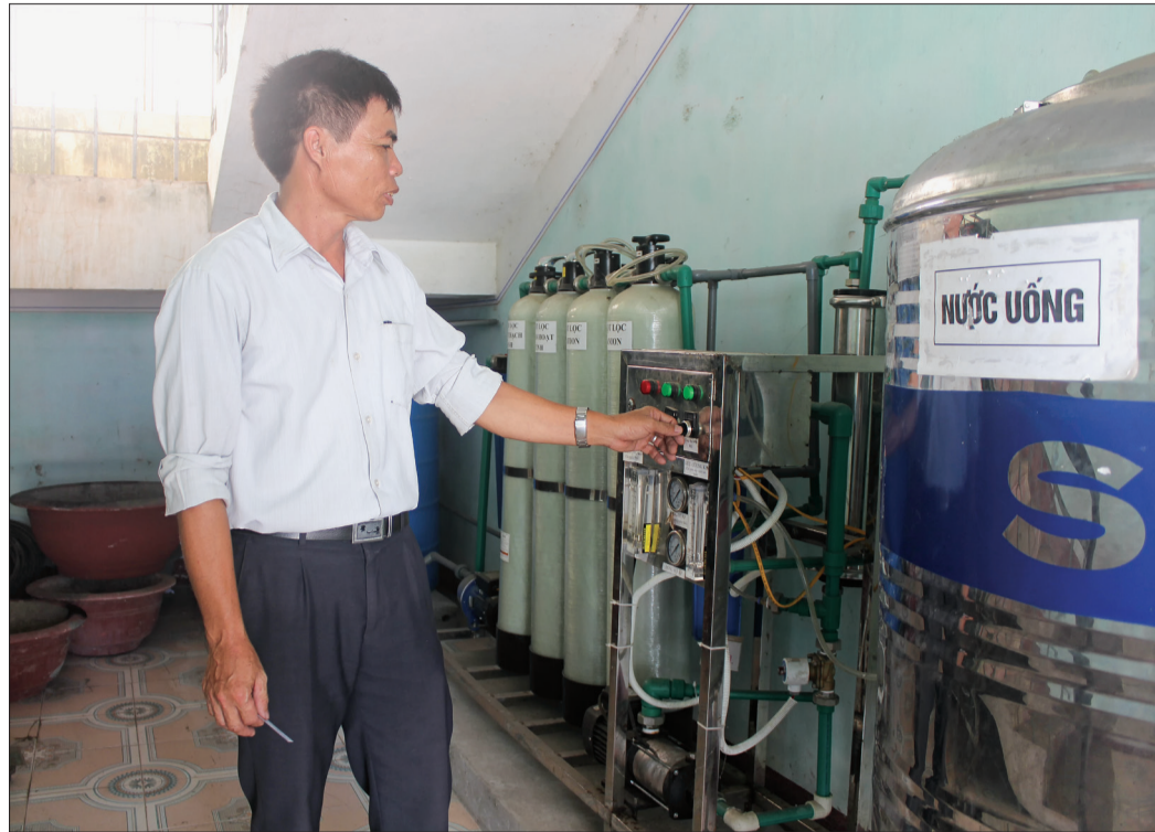
Dàn lọc nước RO ở xã Nam Cường và xã Bắc Hải do GreenID tài trợ.
