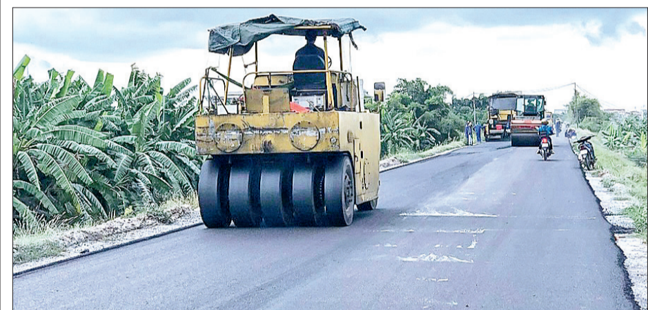
Thi công hoàn thiện mặt đê đê Trà Lý, đoạn từ K25+600 đến K26+785, thành phố Thái Bình.
