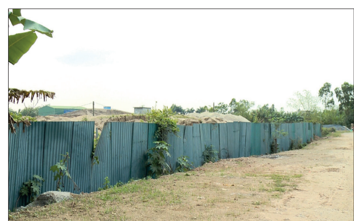
Không chỉ lấn chiếm trái phép hành lang an toàn đê điều, doanh nghiệp còn tự ý dựng tường chắn bằng các tấm tôn.
