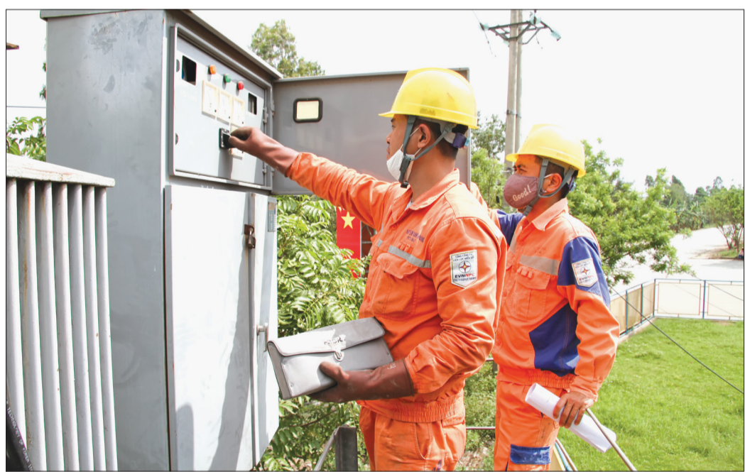
Nhân viên Điện lực Quỳnh Phụ kiểm tra trạm biến áp góp phần giảm tổn thất điện năng.
