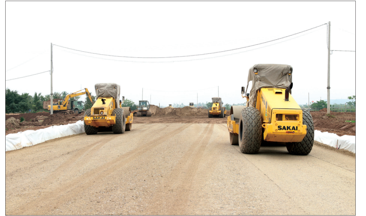
Thi công dự án tuyến đường bộ ven biển, đoạn qua huyện Tiên Hải.
