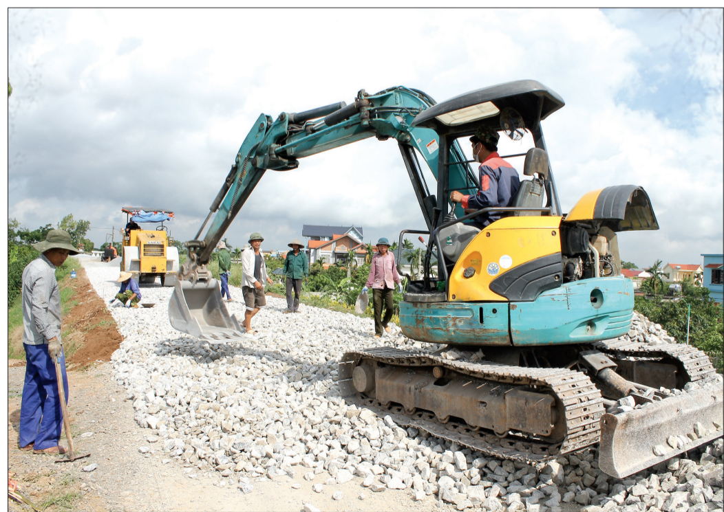
Nâng cấp, mở rộng mặt cắt tuyến đê tả Hồng Hà II đoạn qua địa bàn xã Đông Thanh, Việt Hùng.
