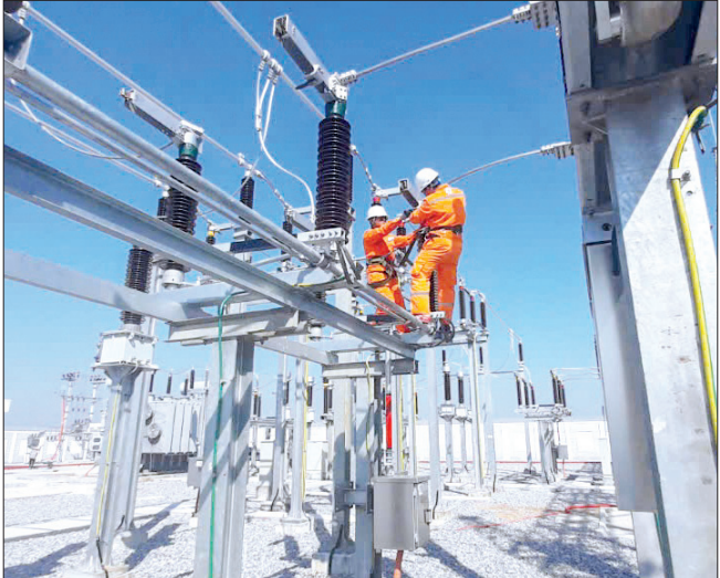
Công nhân Công ty Điện lực Thái Bình cùng nhà thầu đẩy nhanh thi công các công trình điện 110kV.
