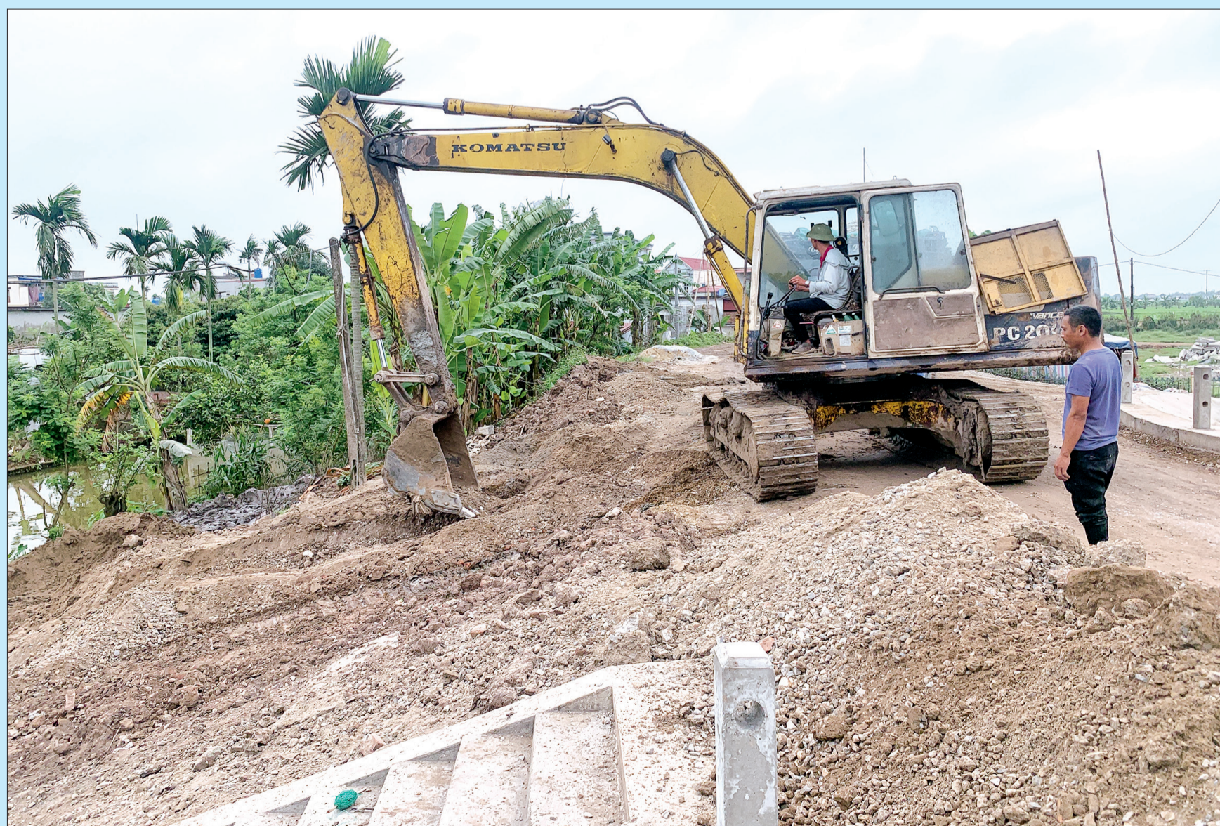
Đơn vị thi công khẩn trương hoàn thiện các hạng mục cuối của công trình cống Ba Xã (xã Hồng Dũng, huyện Thái Thụy).
