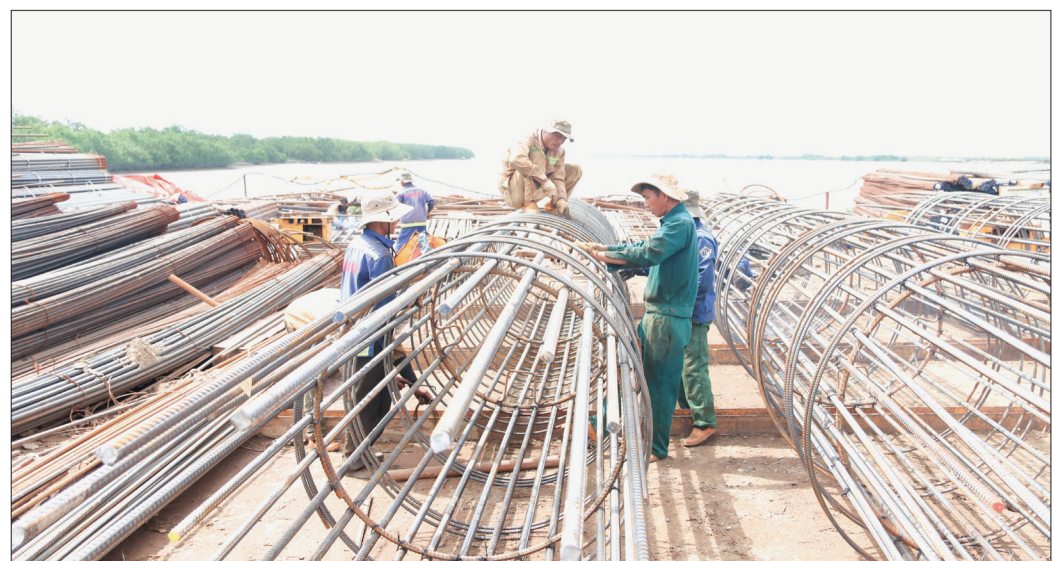
Đơn vị thi công triển khai hạng mục cọc khoan nhồi trụ 20, 21.
