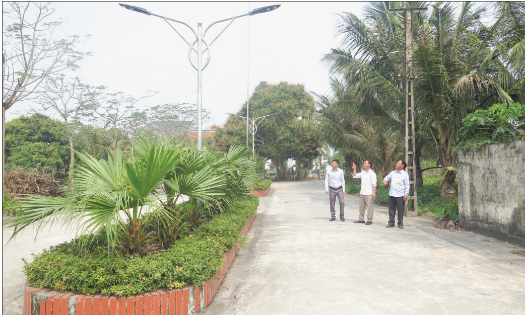
Hệ thống điện thấp sáng đường quê ở xã Thanh Tân.
