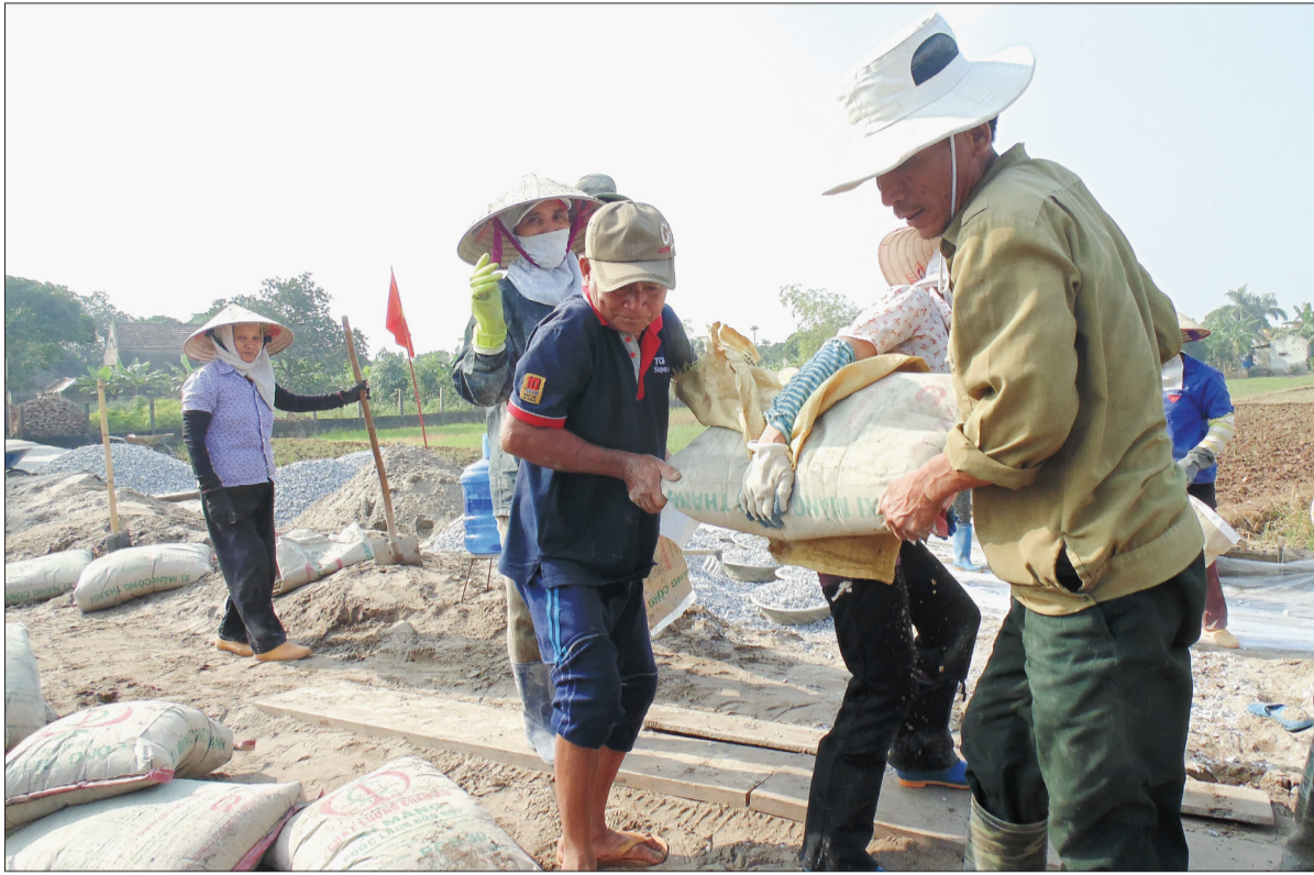
Người dân xã Đông Hòa (thành phố Thái Bình) tham gia làm đường giao thông.
