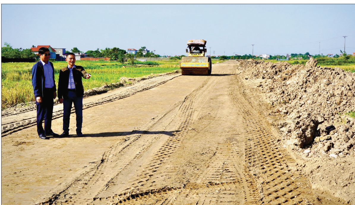
Thi công tuyến đường ĐH.90 trên địa bàn xã Thụy Việt (Thái Thụy).
