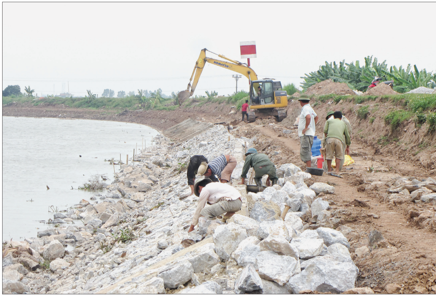
Công trình xây dựng kè Tô Trang, xã An Mỹ (Quỳnh Phụ).
