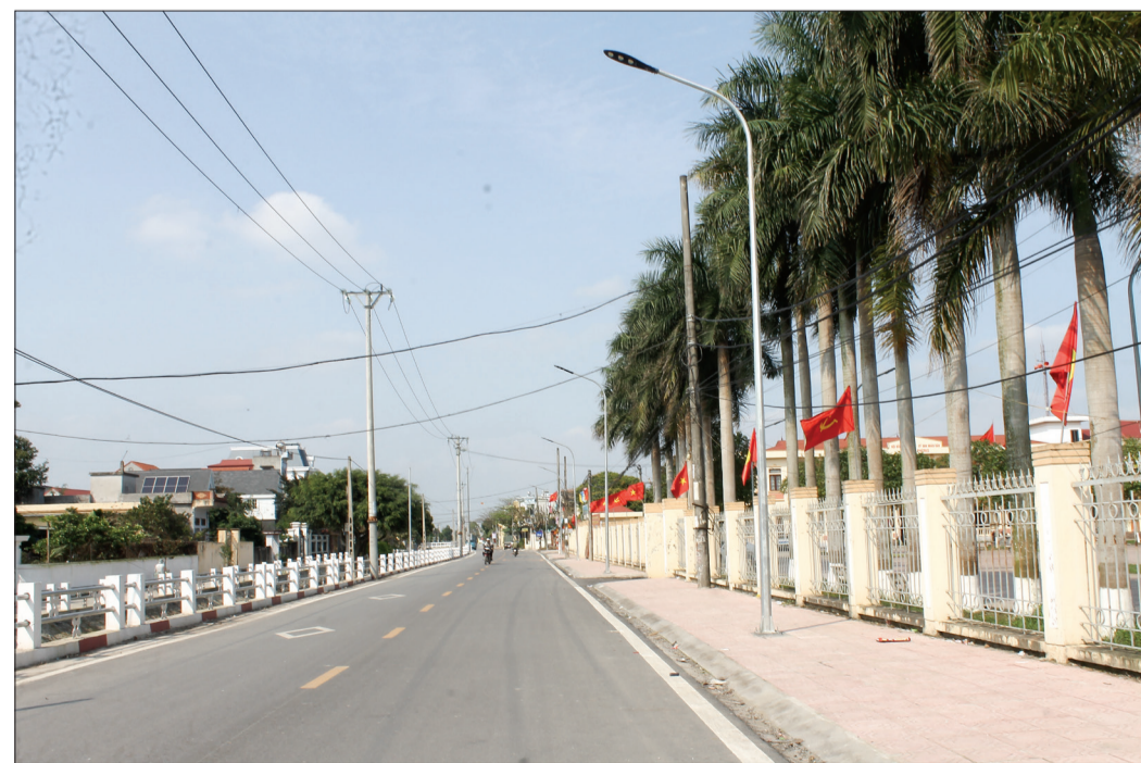
Tuyến đường cứu hộ, cứu nạn cũng là trục giao thông chính của xã Tân Phong (Vũ Thư) được lắp đặt hệ thống chiếu sáng tạo thuận lợi cho nhân dân khi tham gia giao thông.
