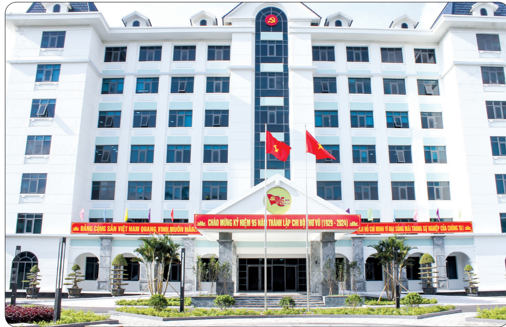
Trụ sở Huyện ủy Vũ Thư, công trình chào mừng 95 năm thành lập Chi bộ Thư Vũ (1929 - 2024), 55 năm thành lập huyện Vũ Thư (1969 - 2024).
