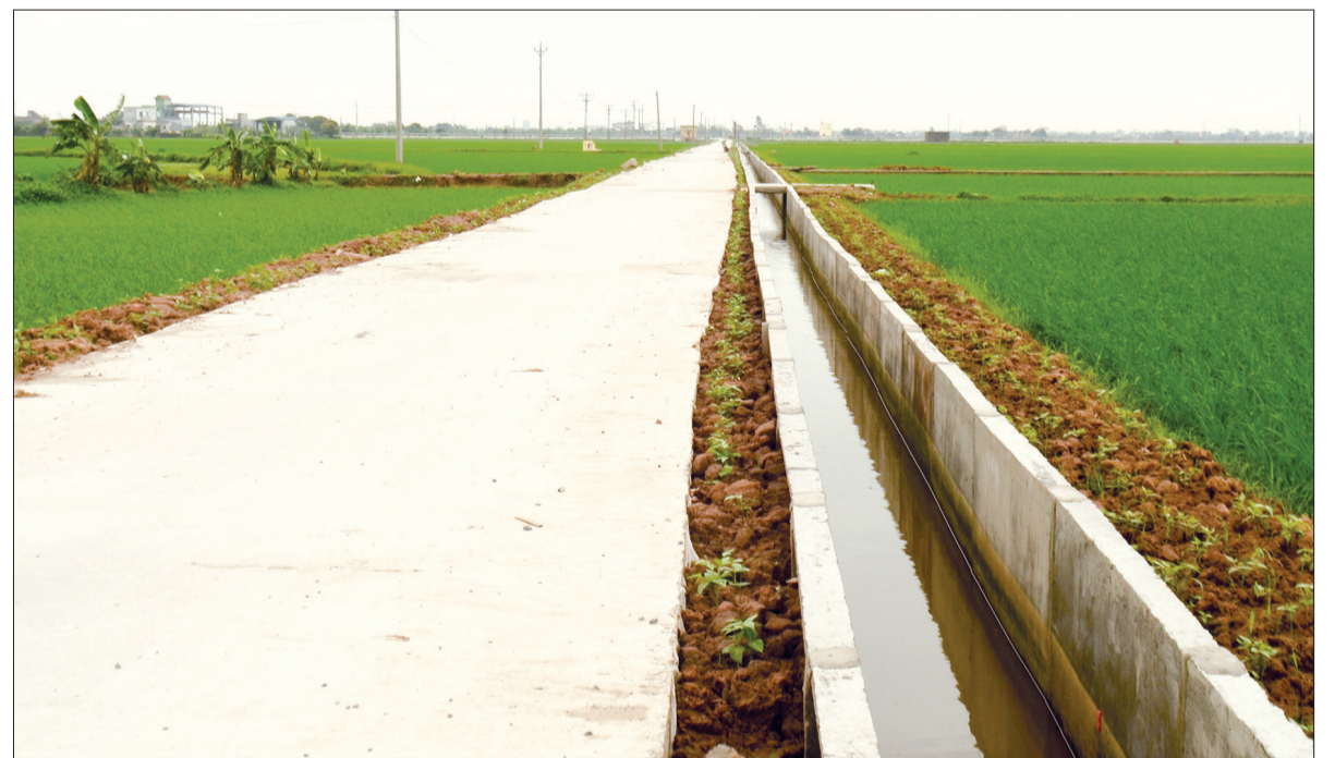
Đường giao thông, thủy lợi nội đồng ở xã Nam Bình được bê tông hóa.
