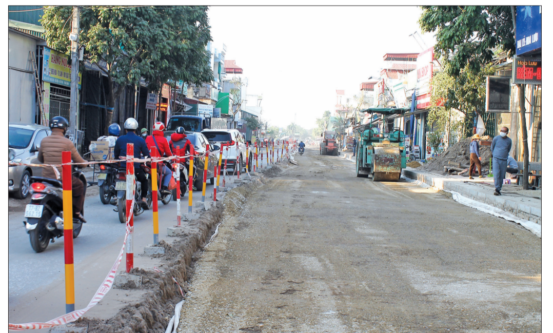
Dự án đầu tư xây dựng tuyến đường tỉnh 454 đang thi công đoạn qua địa bàn xã Vũ Hội.
