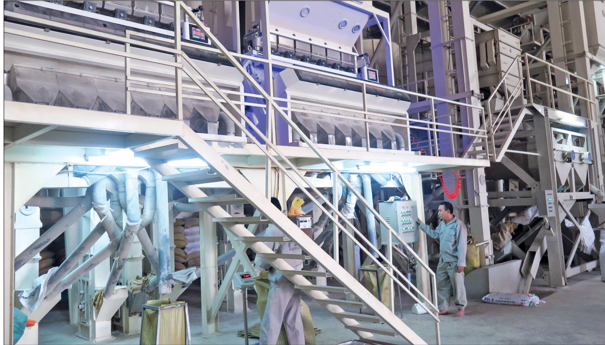
Dây chuyền sản xuất của Công ty TNHH Liên Hạnh (cụm công nghiệp thị trấn Vũ Thư).
