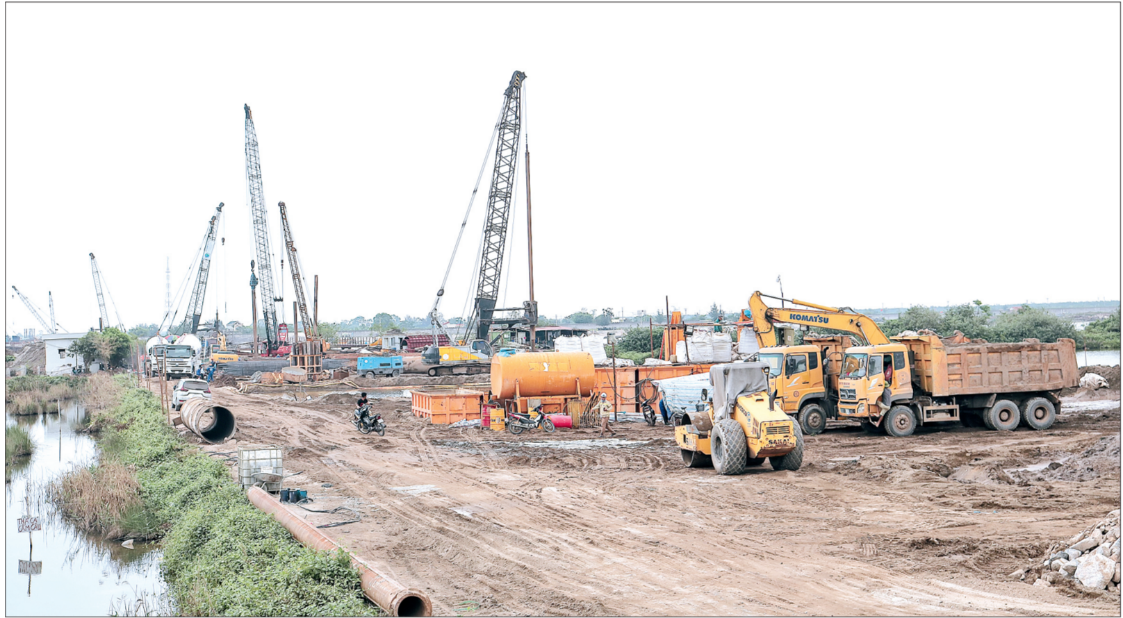
Thi công cầu Trà Lý nối hai huyện Thái Thụy - Tiền Hải trong dự án tuyến đường bộ ven biển tỉnh Thái Bình.
