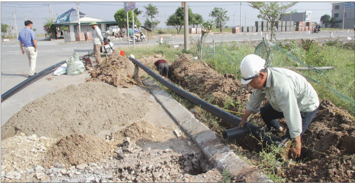
Công nhân Xí nghiệp nước Tiên Hải cải tạo đường ống dẫn nước tại khu vực xã Đông Lâm.
