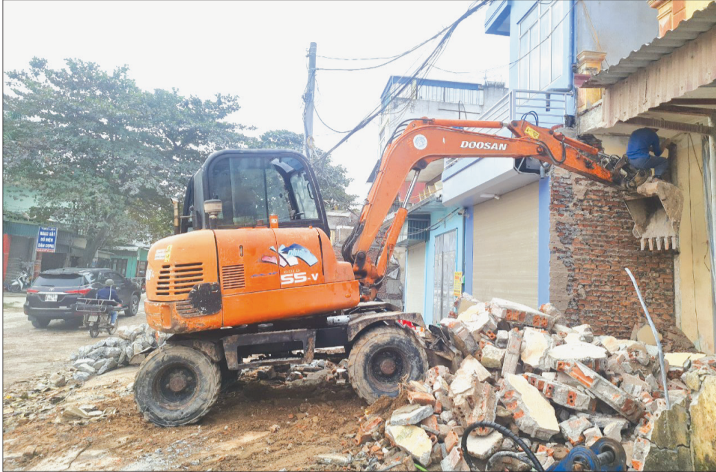
Đẩy nhanh tiến độ giải phóng mặt bằng tuyến đường 454 từ thành phố Thái Bình đến cầu Sa Cao.
