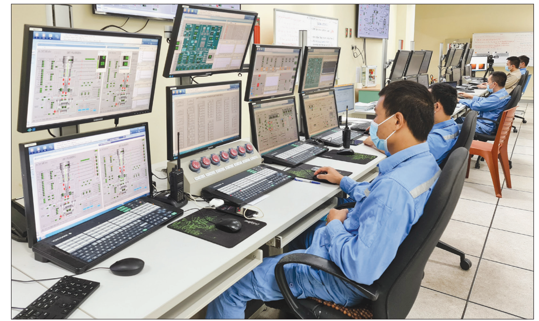
Cán bộ, công nhân viên Công ty Nhiệt điện Thái Bình vận hành các tổ máy sản xuất điện.
