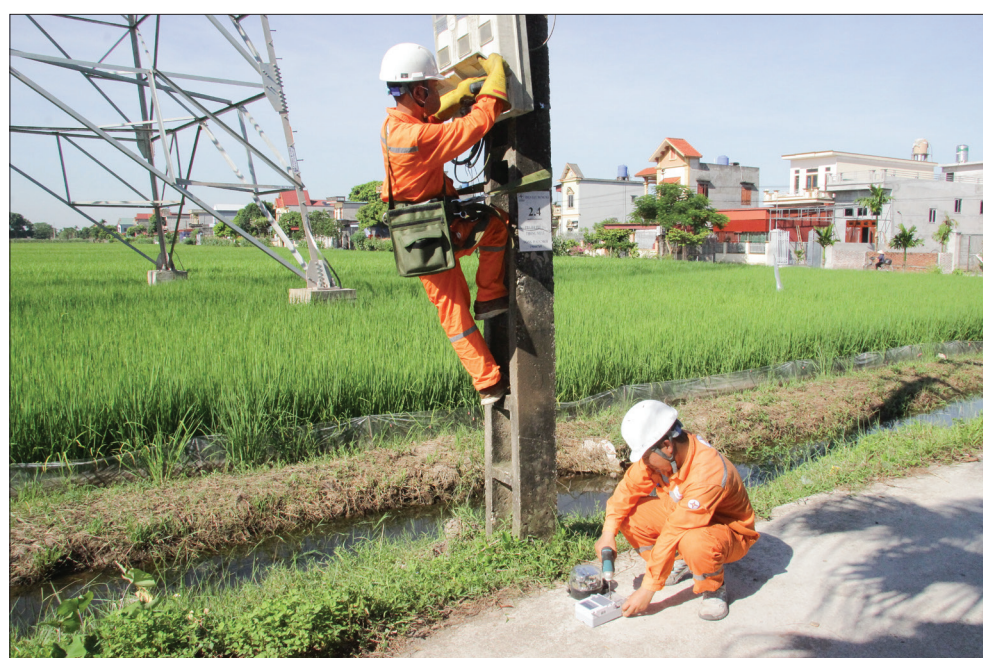
Công nhân Điện lực Hưng Hà lắp công tơ điện từ đo xa cho khách hàng.
