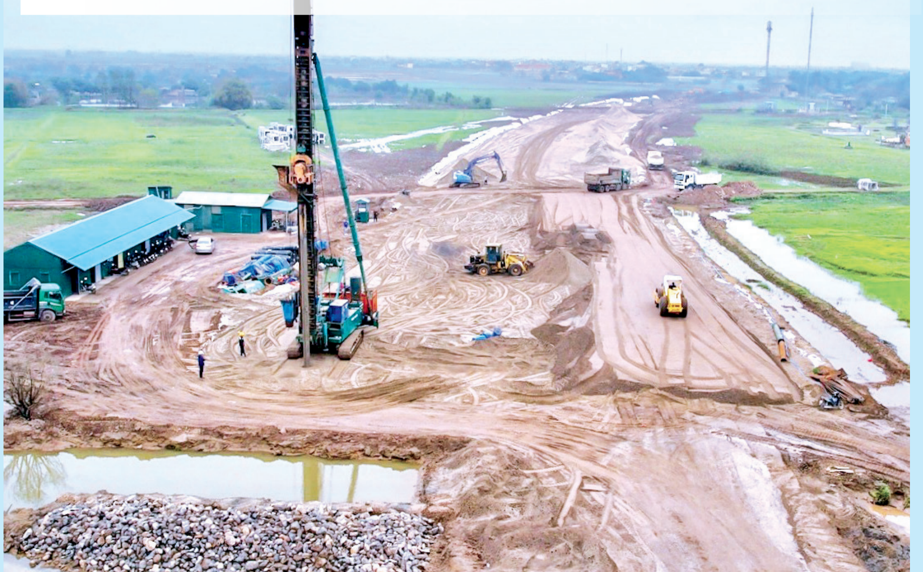
Thi công dự án đường vành đai phía Nam thành phố Thái Bình, đoạn từ cầu gang S1 đến đường Chu Văn An kéo dài.
